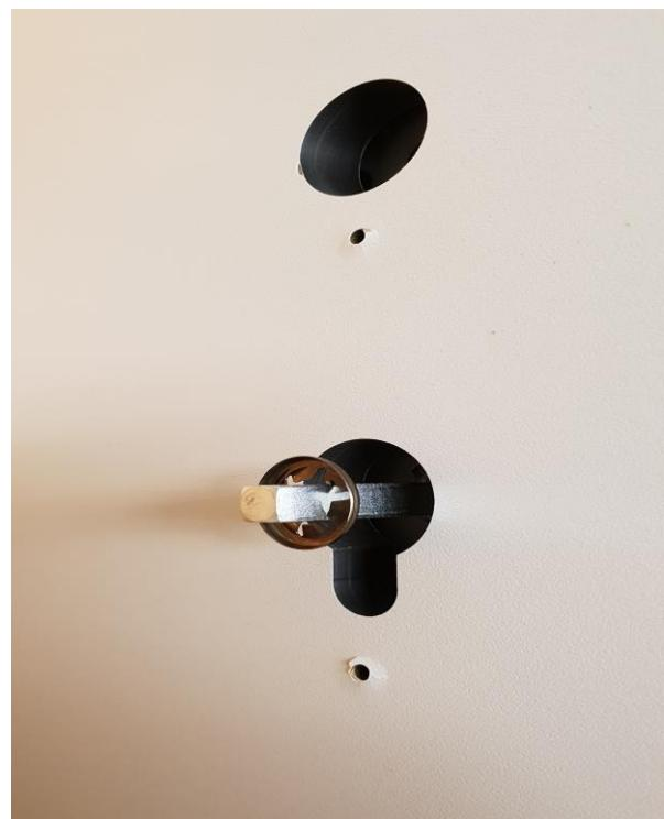
11. Letztes Frontteil montieren. Türschilder, Dreholive von aussen mit Starlock (Metallring) befestigen, Drücker und eventuell Kleiderhaken an der Tür-Innenseite anbringen, LSK 4.8x10.5. **Kunststoffringe** in Türscharnier legen und Türe einhängen. Türpuffer montieren, LSK 4.8x10.5.
